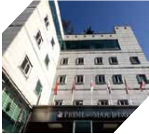
프라임인서울호텔 | 객실관리 / 도어락 설치
