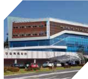
강원체육회관 | 객실관리 / 도어락 설치
