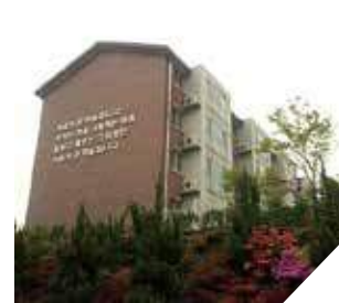
가톨릭대 기숙사 | 객실관리 / 도어락 설치
