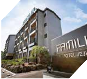
제주파밀리아호텔 | 객실관리 / 도어락 설치
