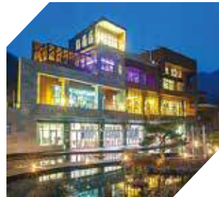
HS 빌 | 객실관리 / 도어락 설치
