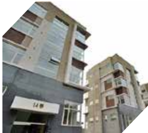
용인대 더원하우스 | 객실관리 / 도어락 설치
